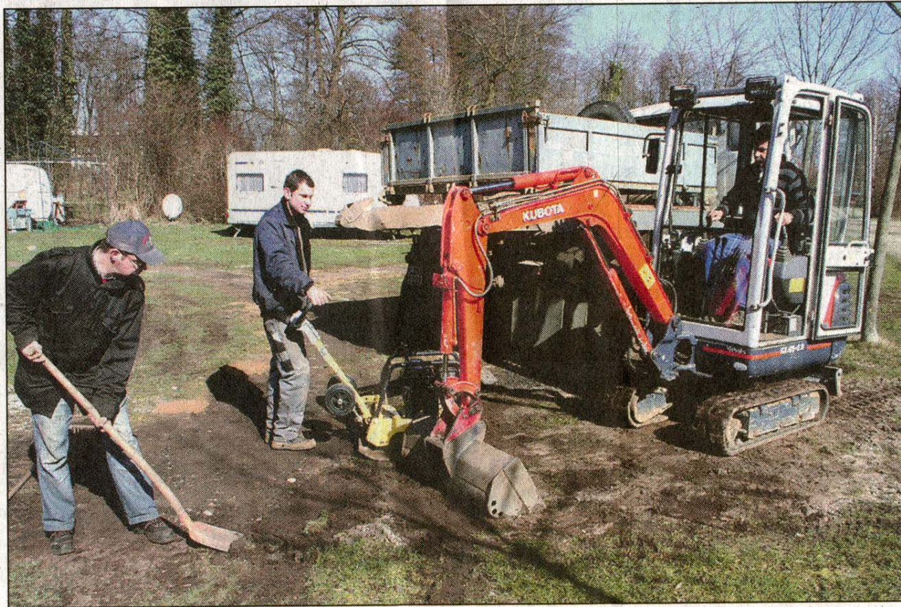
Gino Fubel, Mitarbeiter des Campingplatzes (links), mit der Firma Meißner beim Verlegen einer Dränage zur Entwässerung von Stellplätzen. Foto: jh
